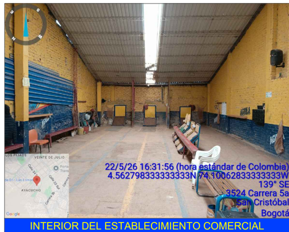
INTERIOR DEL ESTABLECIMIENTO COMERCIAL
